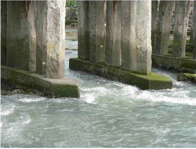
何事も基礎が大事。祇園橋もしっかりと強固な岩盤が支えている。ただし、コンクリートは近年の補修。
